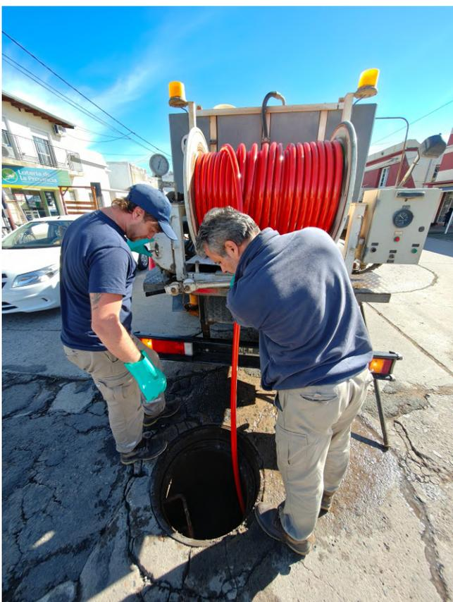
para las colectoras principales, se le realizó el recambio de la manguera principal, con el con el objetivo de procurar un mantenimiento del mismo y su correcto funcionamiento.
